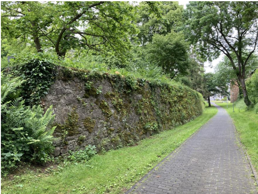
Abbildung 2: Die nordwestliche Kontermauer unterhalb der Bocciabahn ist eine Natursteinmauer mit spezifischem Bewuchs und besonderem Schutzstatus.
